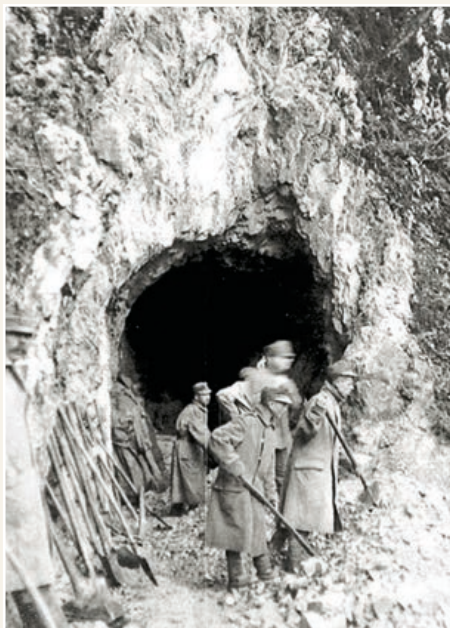
Gradnja predora na trasi ozkotirne železnice na motoriziran pogon v Strugu
