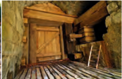
Klavžna vrata z mehanizmom za odpiranje
